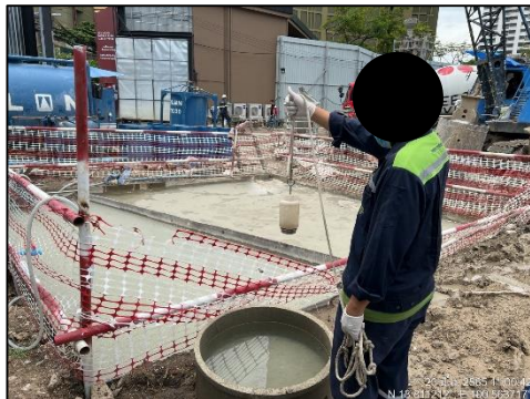
ภาพที่ 29 ป่อพักน้ำทิ้งก่อนระบายน้ำลงสู่สาธารณะ
