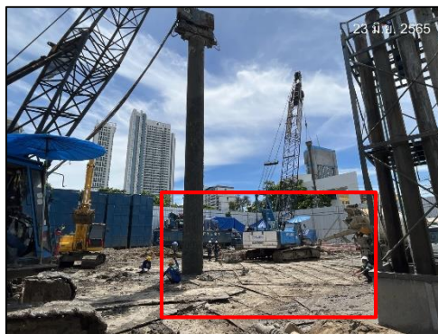
ภาพที่ 50 แผ่นเหล็กปูบริเวณพื้นที่โครงการที่จะมีรถวิ่งผ่าน
