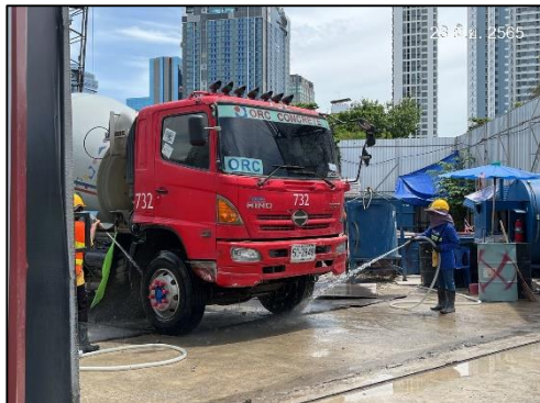
ภาพที่ 49 พื้นที่ทำความสะอาดล้อรถบรรทุกก่อนออกจากโครงการ (ต่อ)
